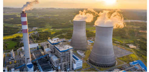
Centrale thermique à charbon
